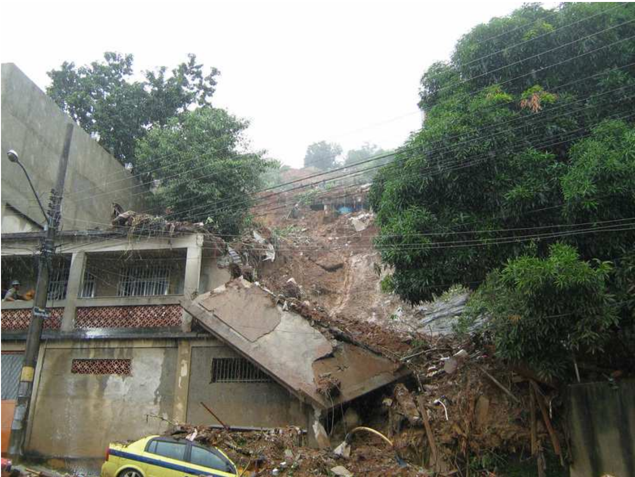
Foto 09 – Vista do trágico escorregamento e da rocha que aflora após o acidente, indicando um perfil de intemperismo delgado.
