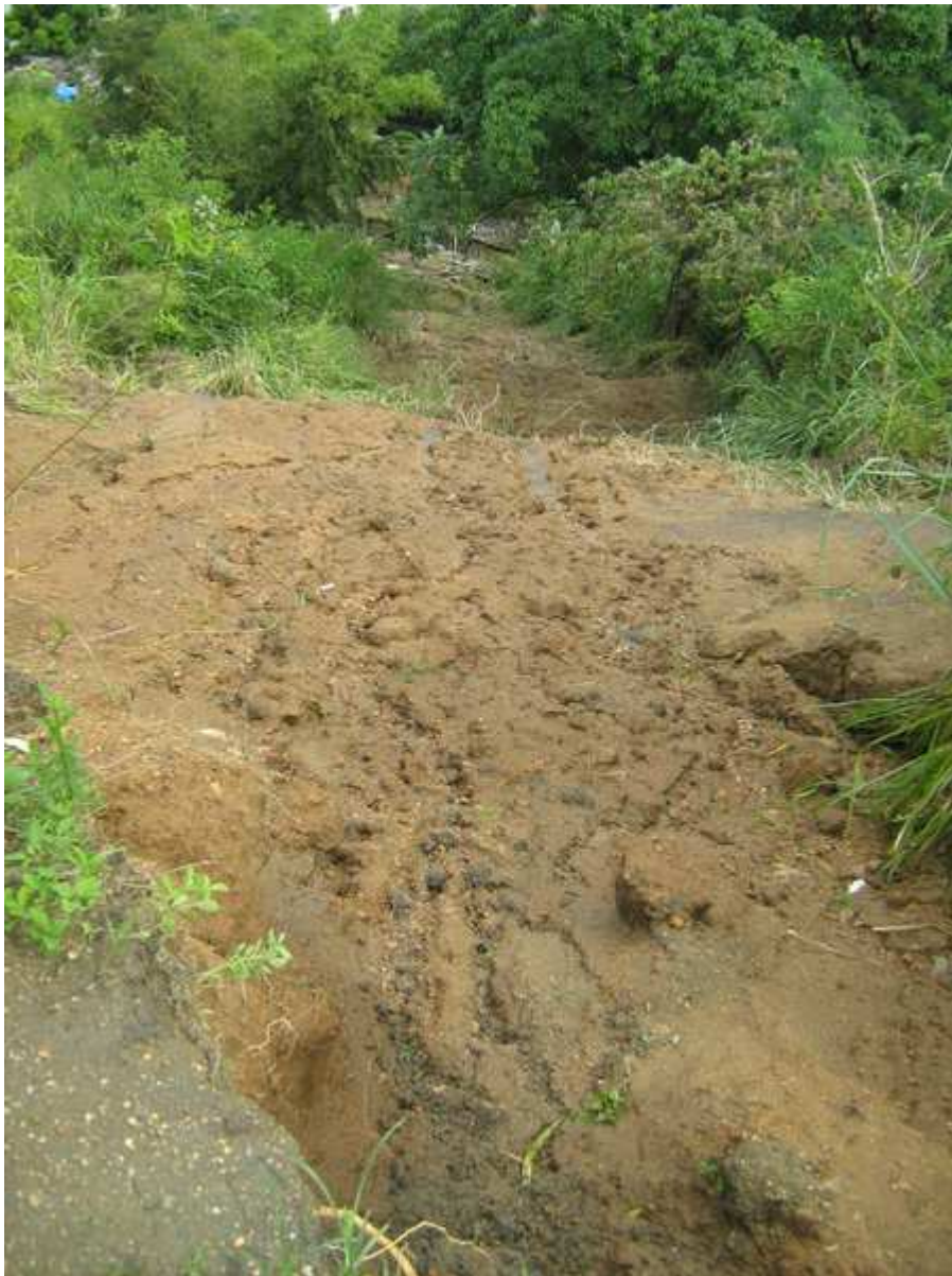
Foto 06 - Escorregamento que atingiu 4 casas e destruiu 03, na área da rua Luiz Vargas.
