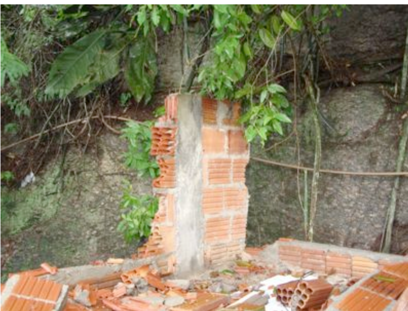
Foto 4 - Tirada de laje de casa adquirida e sendo demolida pela Prefeitura
