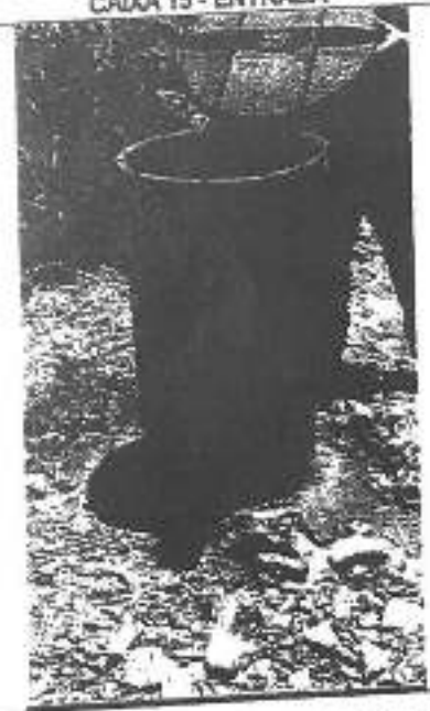
CAIXA 15 - SAÍDA - DISPOSIÇÃO DE EFLUENTE NO SOLO
