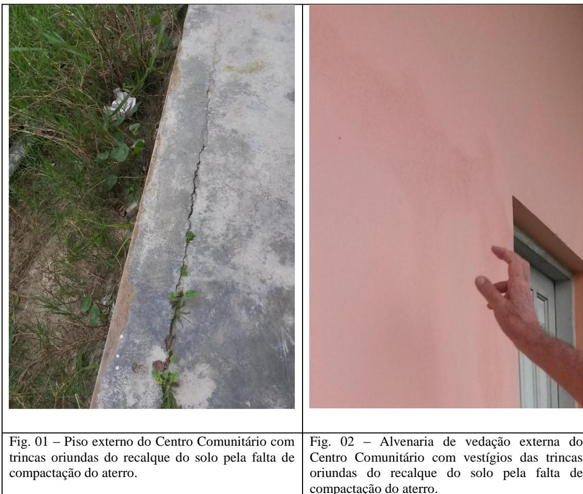
Fig. 01 – Piso externo do Centro Comunitário com trincas oriundas do recalque do solo pela falta de compactação do aterro.
