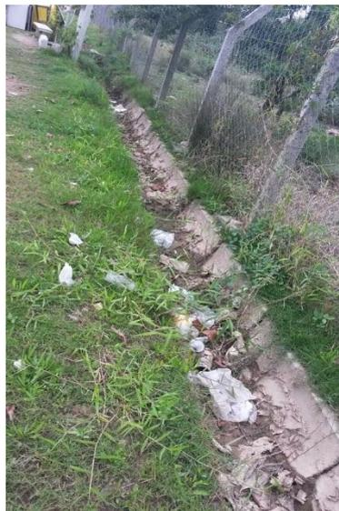
Fig. 02 – Acúmulo de lixo na calha de drenagem que separa área de proteção ambiental.
