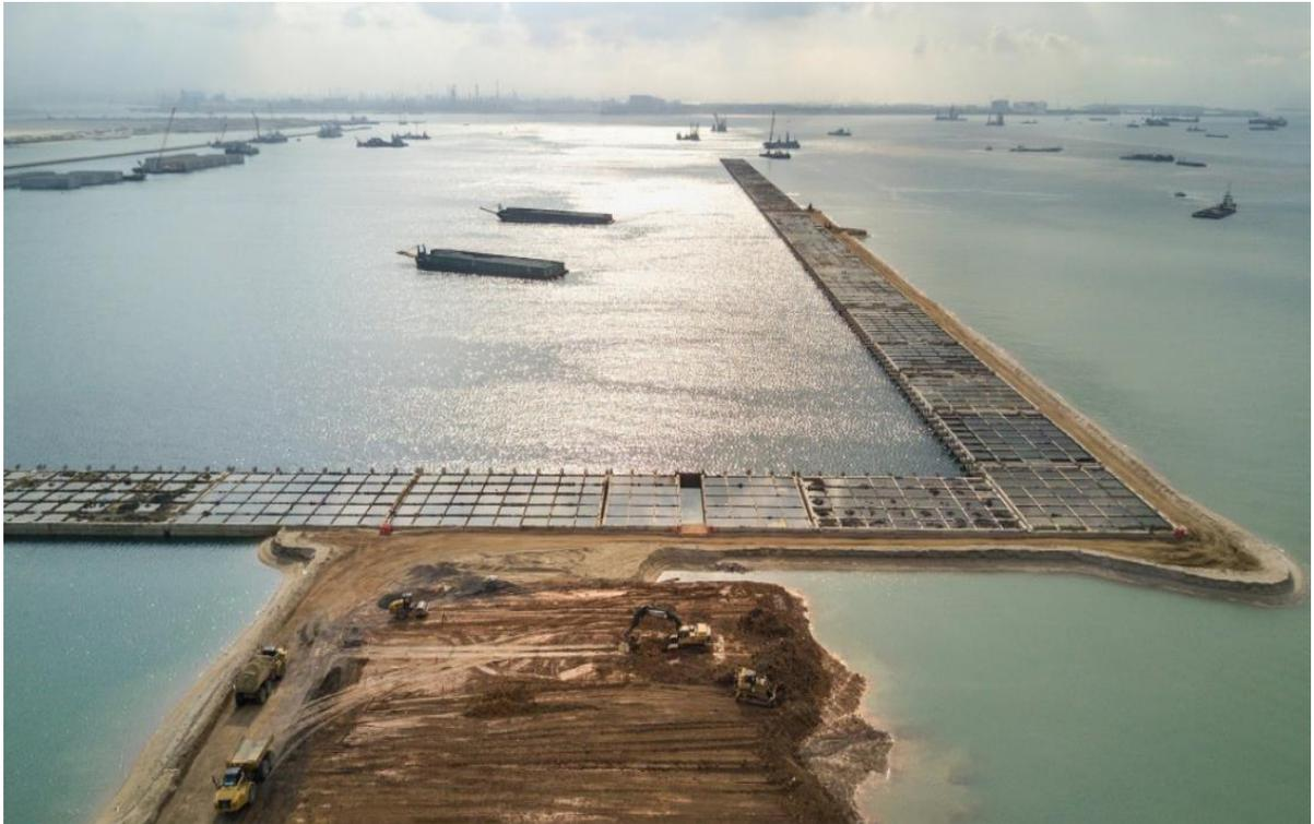
**FIGURA 10.** Outra visão do projeto do terminal. Os caixotes serão unidos para formar um muro de contenção para um dos pilares onde embarcarão. Crédito Sim Chi Yin / VII, para The New York Times.
