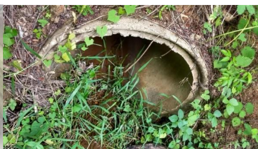
Figura 11b – Tubulação B.
