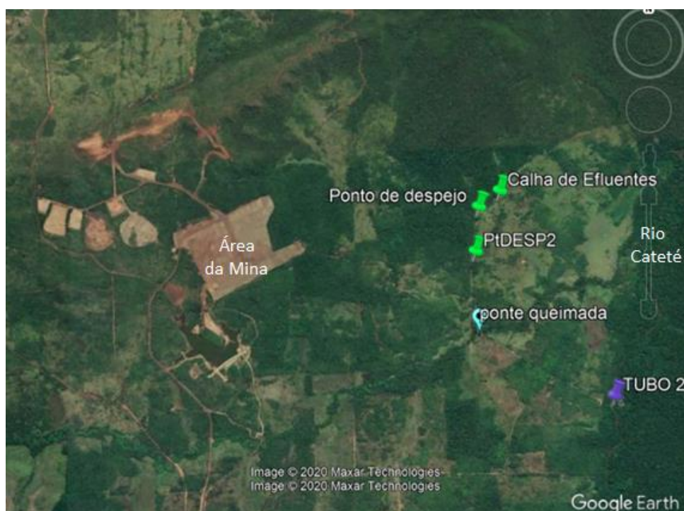
Figura 12 - Localização da estrada com calhas e tubos de escoamento de dreno da mina.
