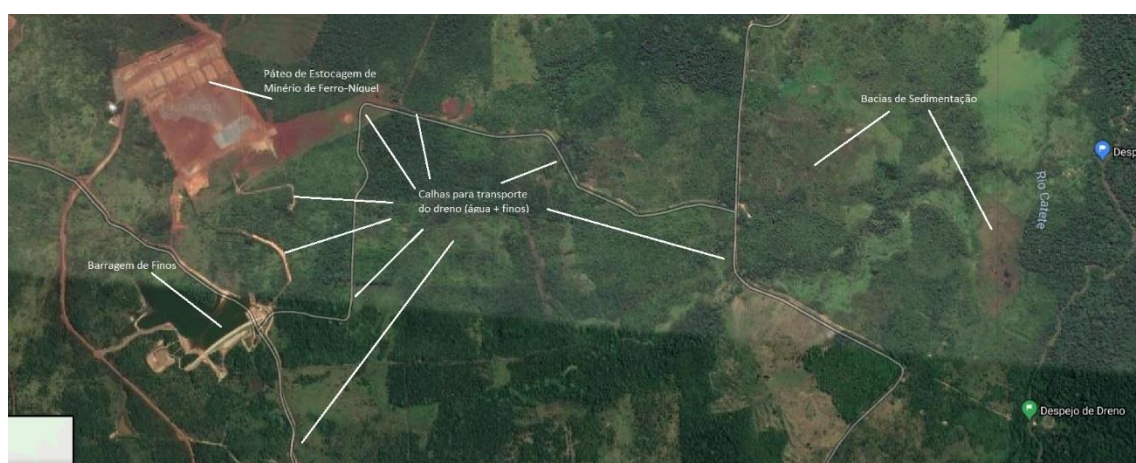
Figura 13 - Localização de calhas e bacias de estocagem de dreno.
