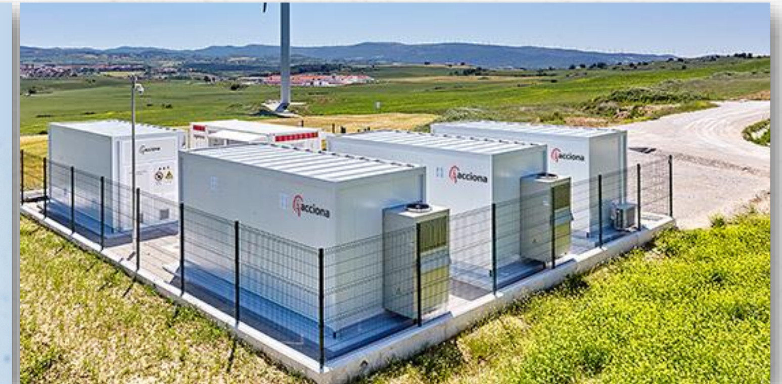
Armazenamento com baterias
