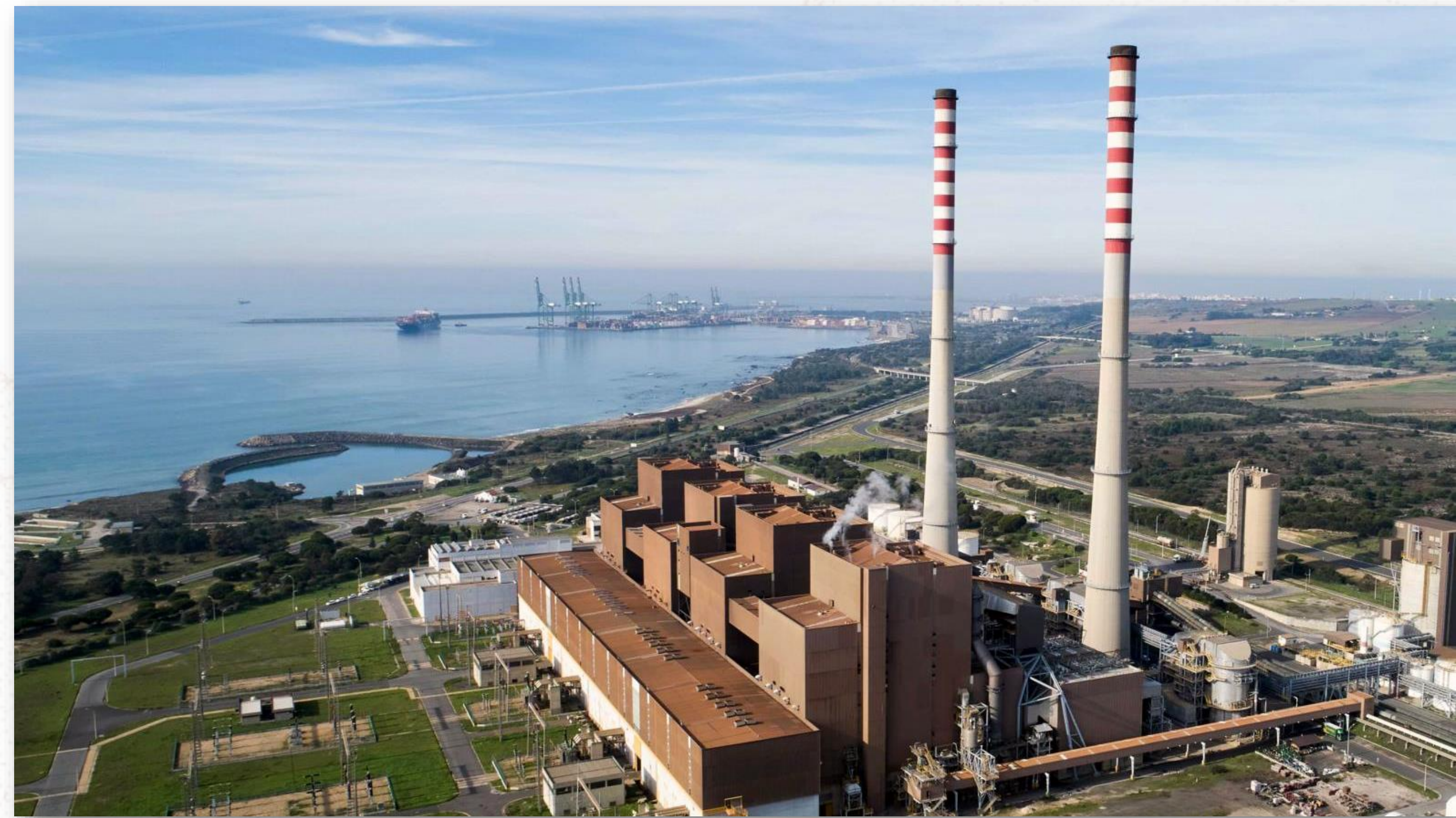
Central Termoelétrica de Sines
