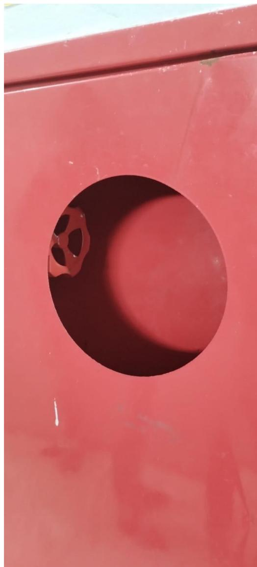
Em caso de incêndio, a saída de emergência trancada em uma das pontas do andar superior e a falta de mangueira para combate a incêndio prenunciam uma tragédia.
