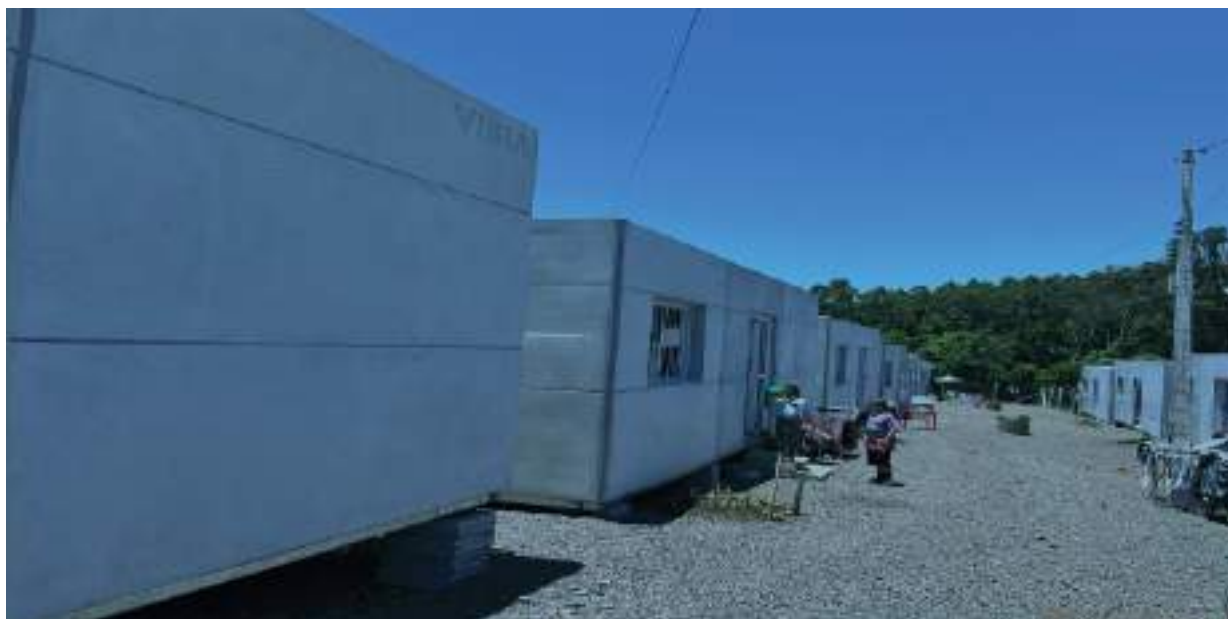
↑ As moradias provisórias instaladas em contêineres no município de Estrela, as áreas habitadas ainda assim ficam próximas aos pontos que foram afetados pelas inundações. © Anistia Internacional Brasil.
