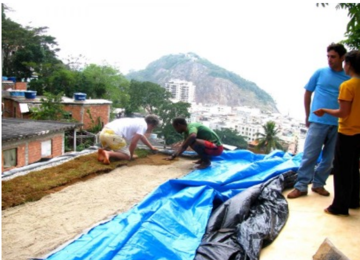
Figura 2. Execução das camadas do telhado verde (TIBÁ, 2008)
