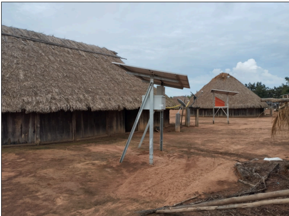
Figura 8. Instalação dos SIGFI 80 nas residências da Aldeia Khikhatxi.
