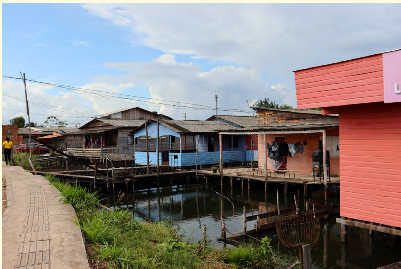
Foto: Casas em área de ressaca no bairro do Congós em Macapá (2024)
