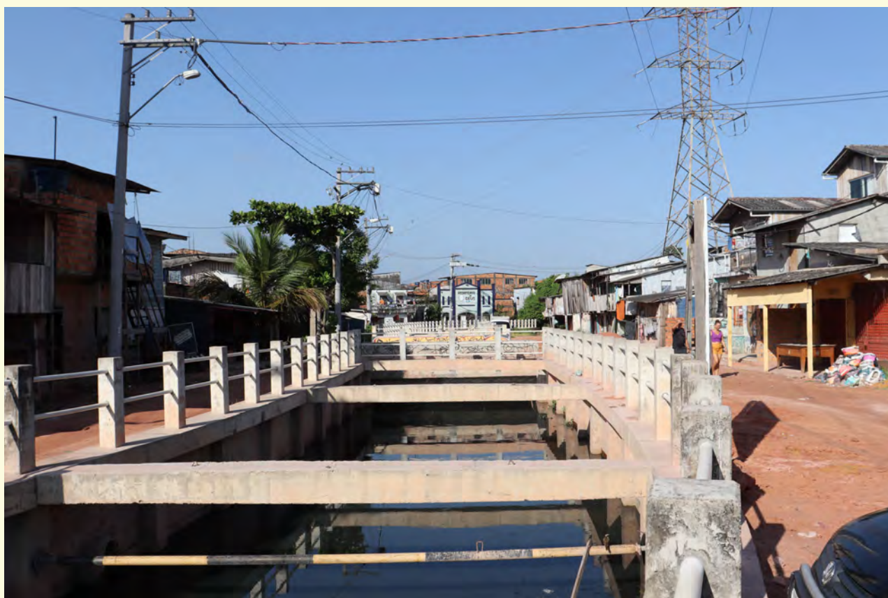
Foto: Obras da Macrodrenagem na Bacia do Tucunduba, em Belém (2024)
