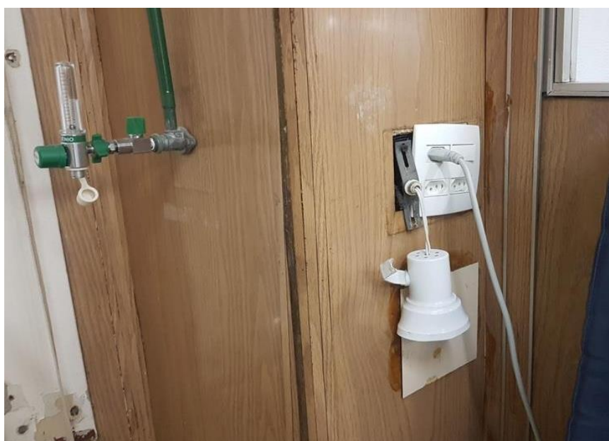
Parte elétrica de baixa tensão, subdimensionada
